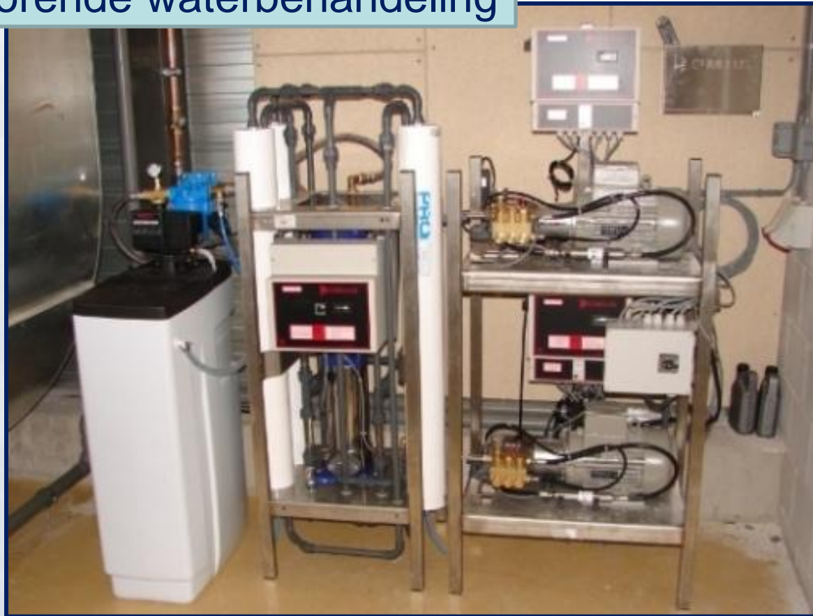
Waterontharder, Omgekeerde-Osmose en Boosterpomp Duo opstelling
